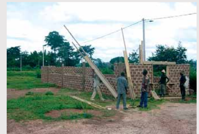
◉ Un momento de la construcción del comedor escolar en la comunidad de Bategue. Sapharm/Global Humanitaria [Foto]
