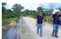
← TÉCNICOS DE GLOBAL HUMANITARIA ATRAVIESAN EL PUENTE CONSTRUIDO POR NUESTRA ORGANIZACIÓN EN LA COMUNIDAD DE LAS FLORES, MACHACA.
