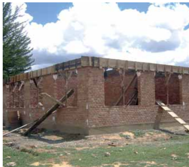
Posta de salud de Chillijchi en plena construcción.
