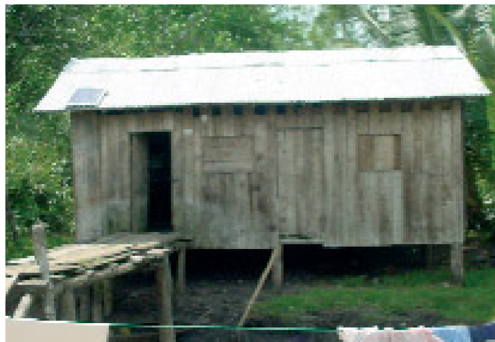
Aspecto exterior de una de las 120 viviendas que tienen instaladas placas solares en su tejado. Global Humanitaria [Foto]
